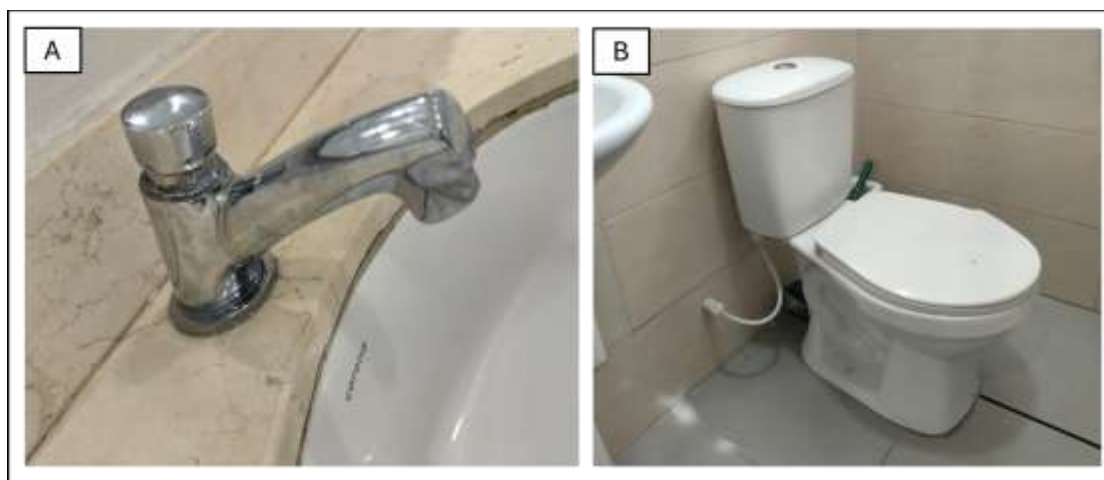
Ilustración 4. Control de consumo de agua (Grifos con sistema push)
